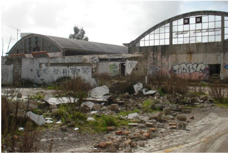
Area industriale dismessa
