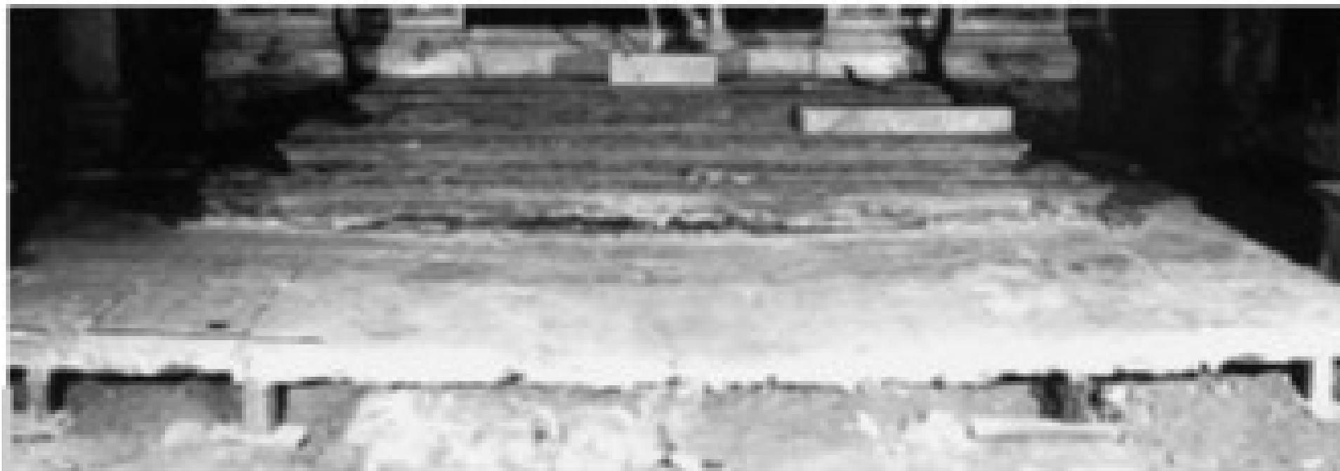
Figura 5 • Smontaggio del rivestimento marmoreo di un pavimento. Anche i sottostanti lastroni, che costituiscono lo “zatterone” in pietra sul quale è posato il pavimento a tarsie, sono stati rilevati, numerati e fotografati prima di procedere alla loro rimozione.
