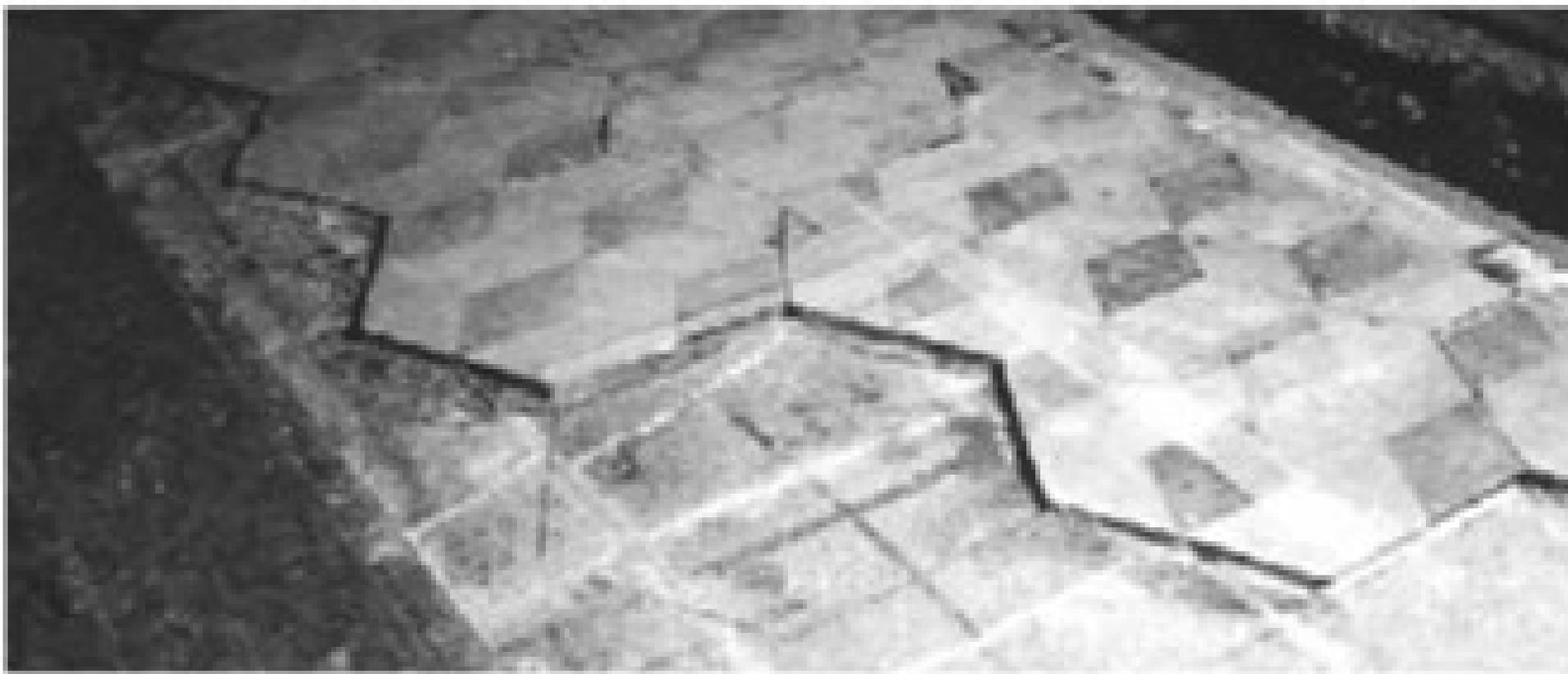
Figura 4 • Smontaggio del rivestimento marmoreo di un pavimento. Stacco delle tarsie per blocchi esagonali formati da dodici elementi ciascuno; ogni blocco è stato trasportato nell'attiguo cantiere di restauro e ripulito con bisturi e solventi dalla resina ancorata sulla faccia inferiore.
