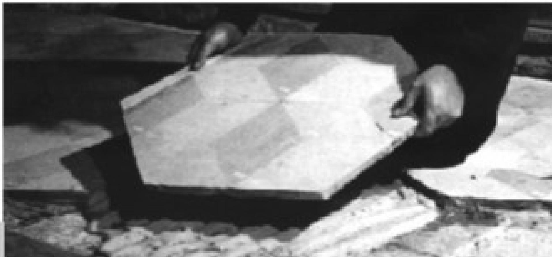
Figura 7 • Smontaggio del rivestimento marmoreo di un pavimento. Dopo aver steso la resina sulla faccia inferiore del primo esagono e sulla superficie corrispondente dello zatterone in pietra, può avvenire la posa del primo elemento. La resina deve essere preparata ogni volta, per ogni singolo pezzo.
