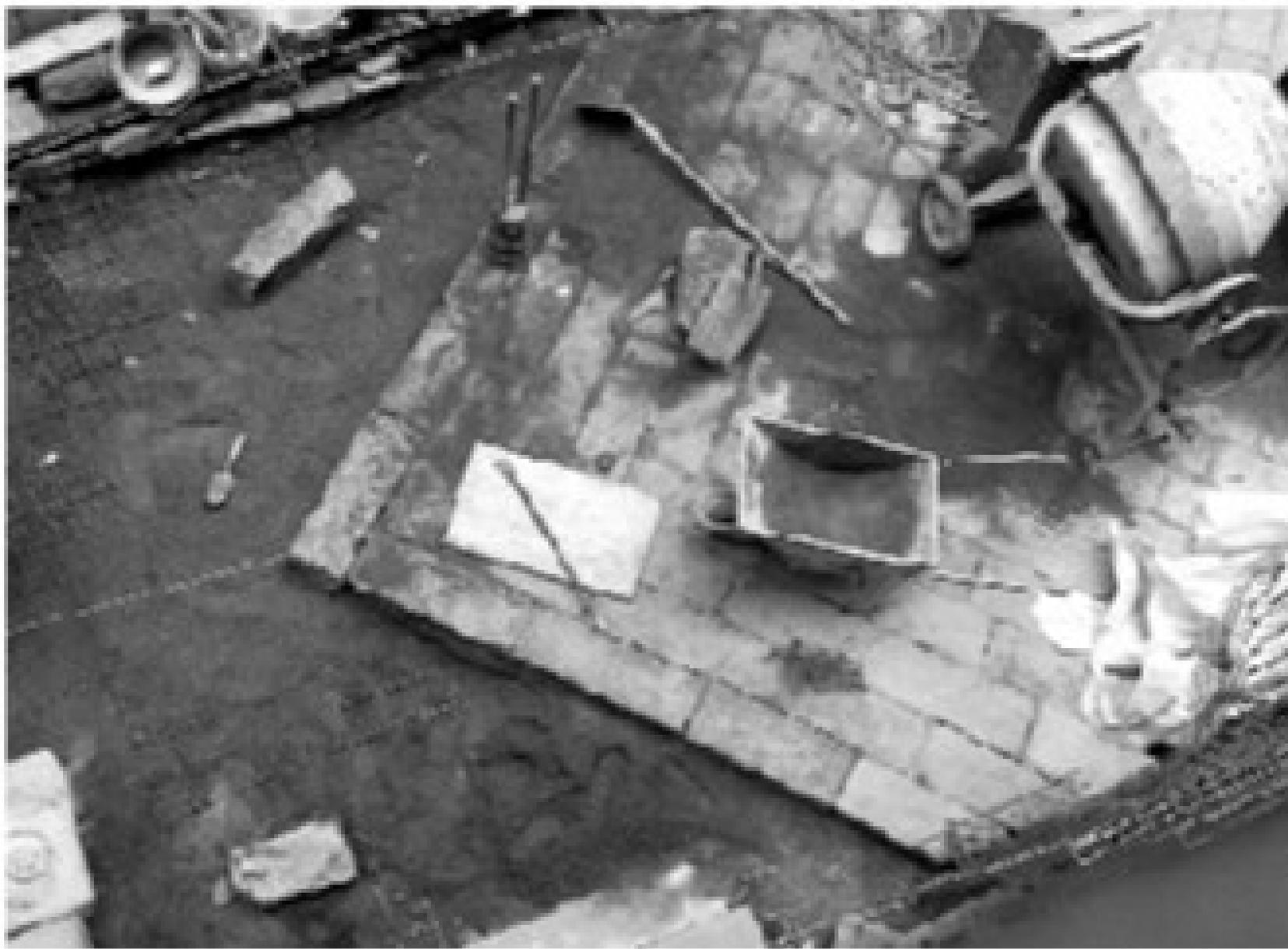
Figura 10 • Fase di rimontaggio della pavimentazione con ricollocazione dei tacchi.
