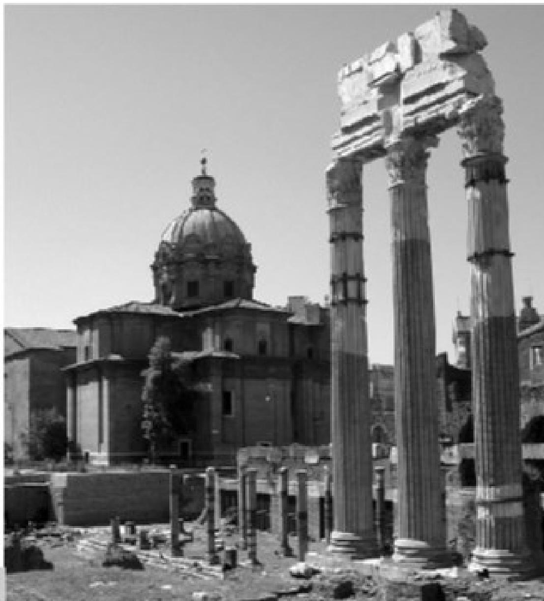
Figura 7 • Colonne ricomposte per anastilosi, con rilevanti integrazioni di pietra scanalata
