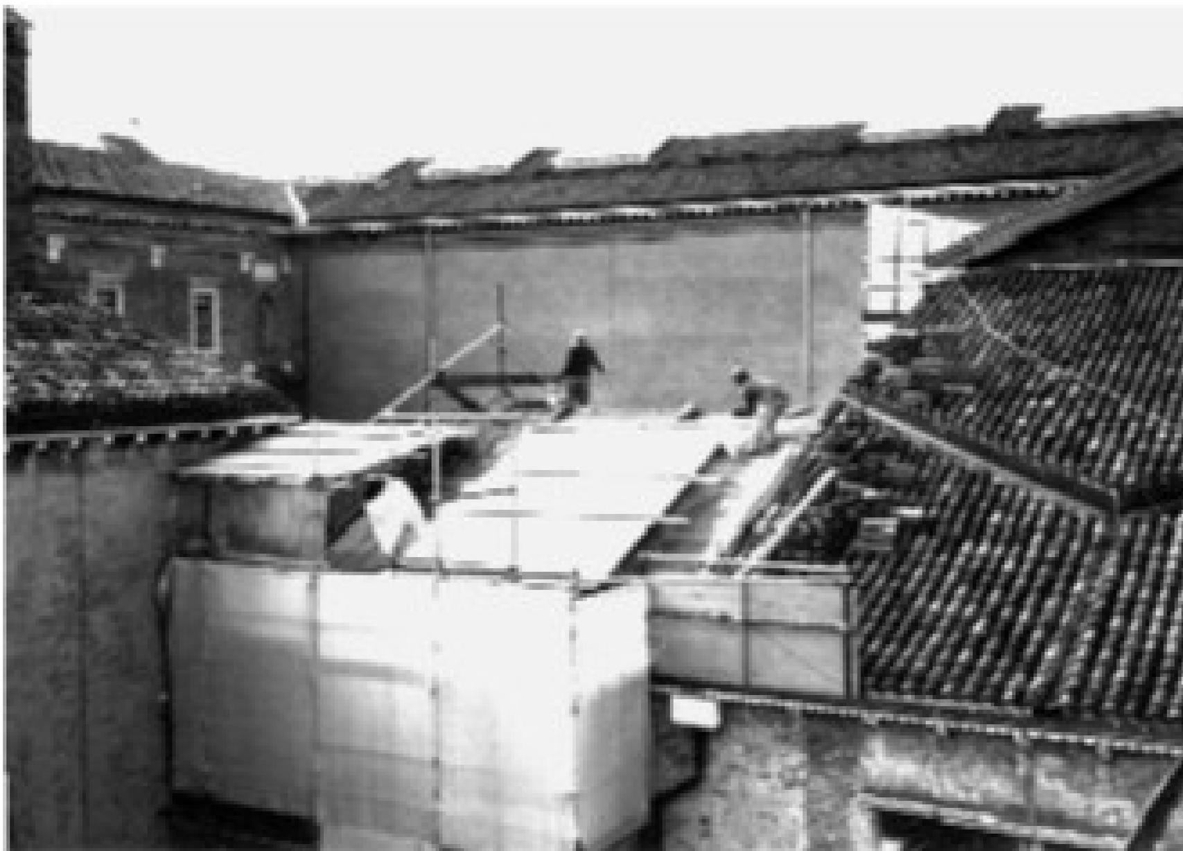
Figura 1 • Smontaggio e rimontaggio di un manto di copertura. Si notino, a sinistra, le coperture provvisorie e, a destra, alcuni coppi accatastati in attesa di essere ricollocati.
