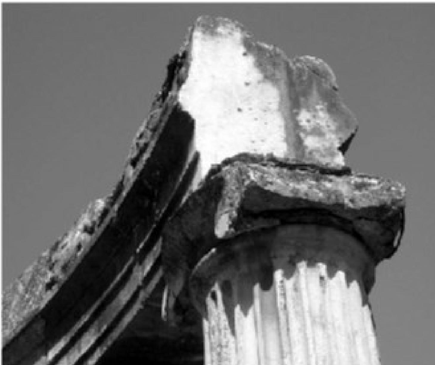
Figura 9 • Ricomposizione con aggiunta di un capitello in calcestruzzo armato.
