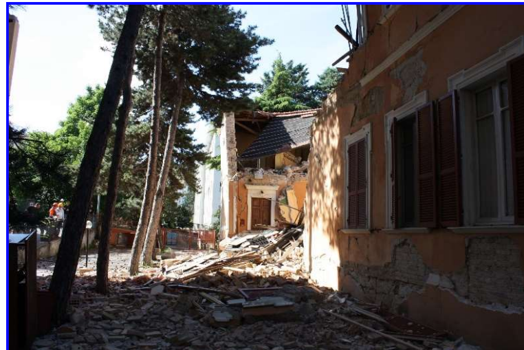
Edificio centro L'Aquila – L'Aquila 2009
