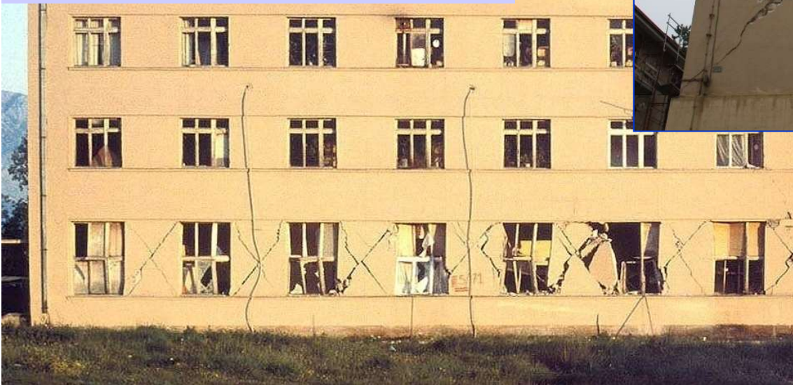
Budva, 1979 - Rottura a taglio dei maschi del piano terra
