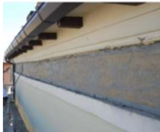
Cordolature di piano con tessuti in acciaio
