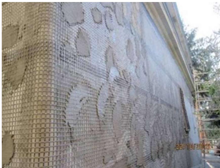
Rinforzo muratura con rete in basalto
