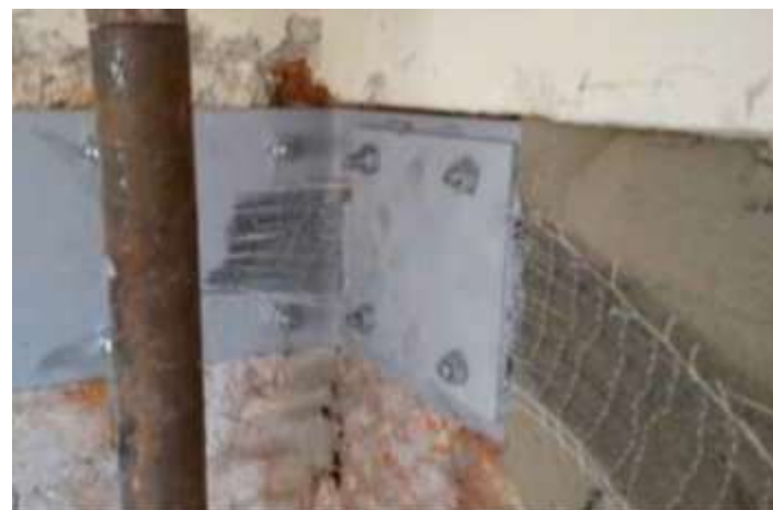
Cordolature di piano con tessuti in PBO
