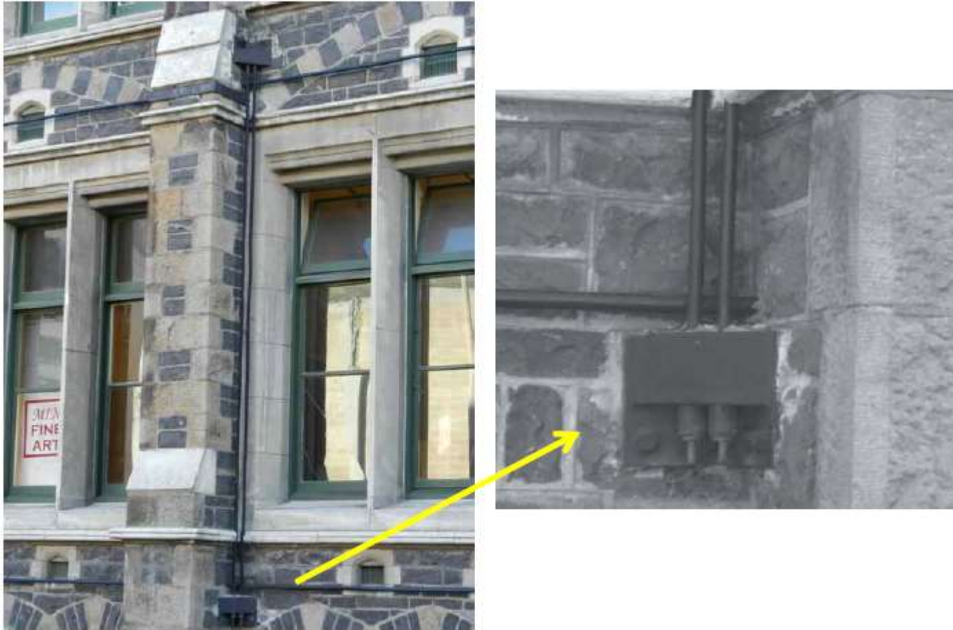
Particolari tirantature verticali e orizzontali post-tese
