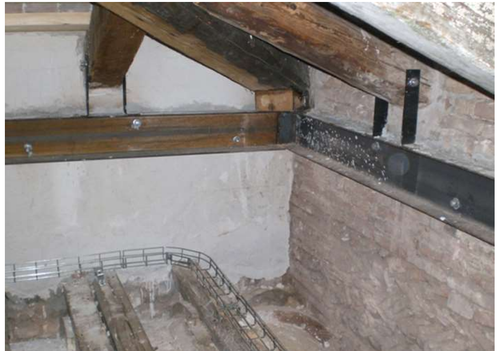
Legature orizzontali in profilati di acciaio spinottati.
