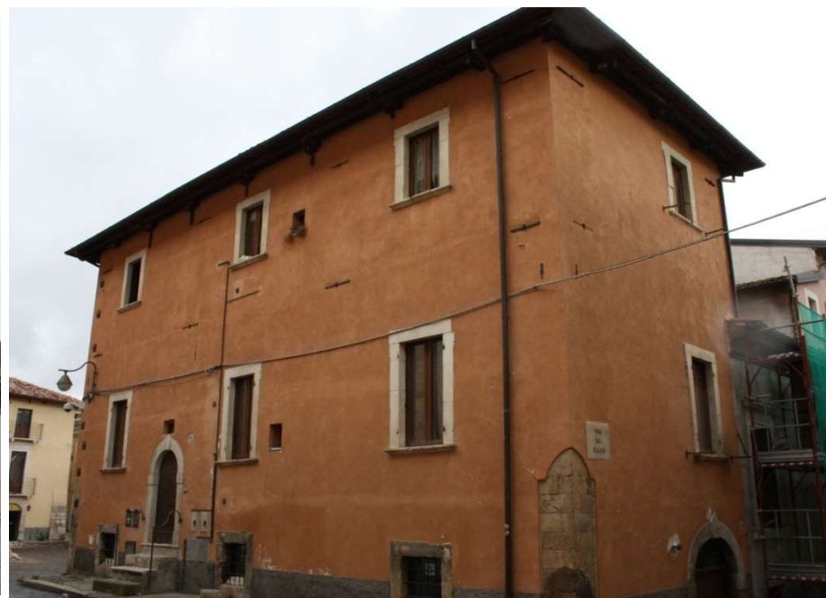
L'Aquila 2009 Edificio ben legato
