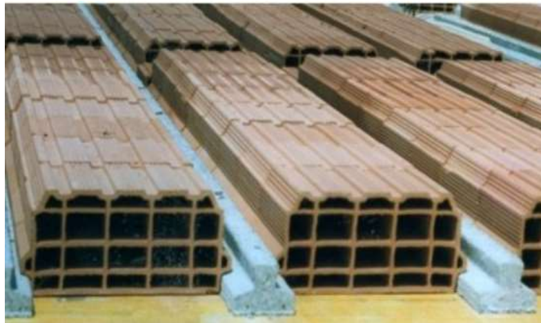
Solai a travetti in precompresso
