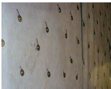
Figura 16- Particolare di fissaggio isolamento a paratia
