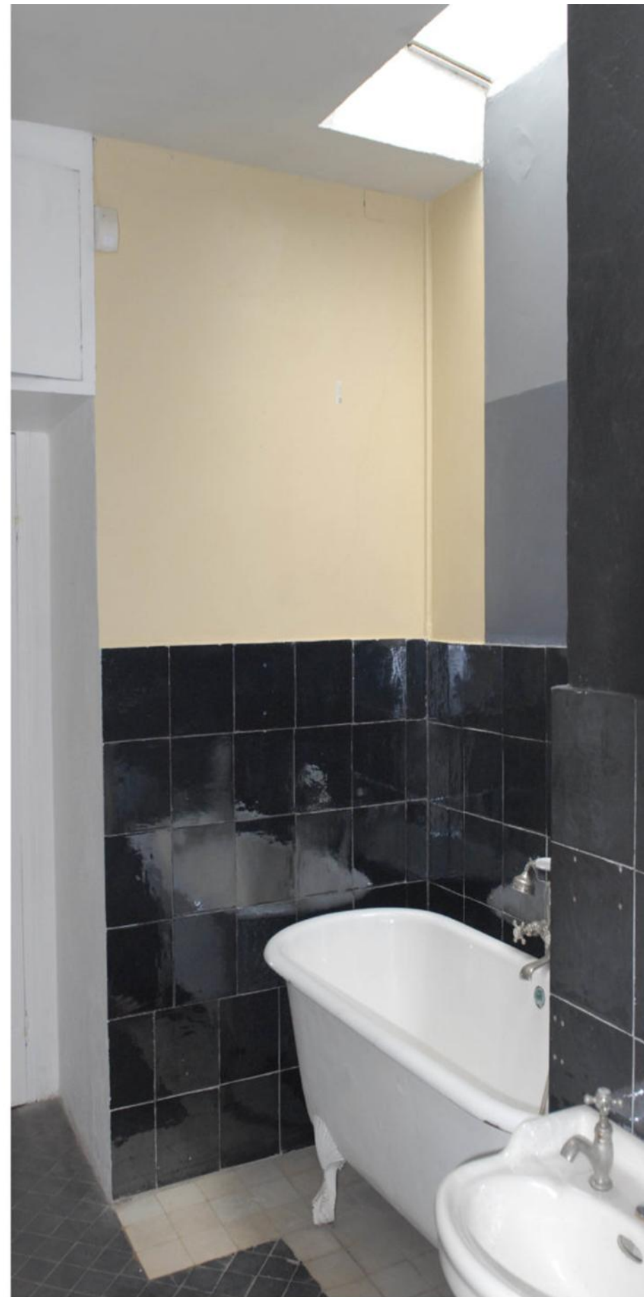
Villa E-1027 - Salle de bain État avant restauration - 2009
