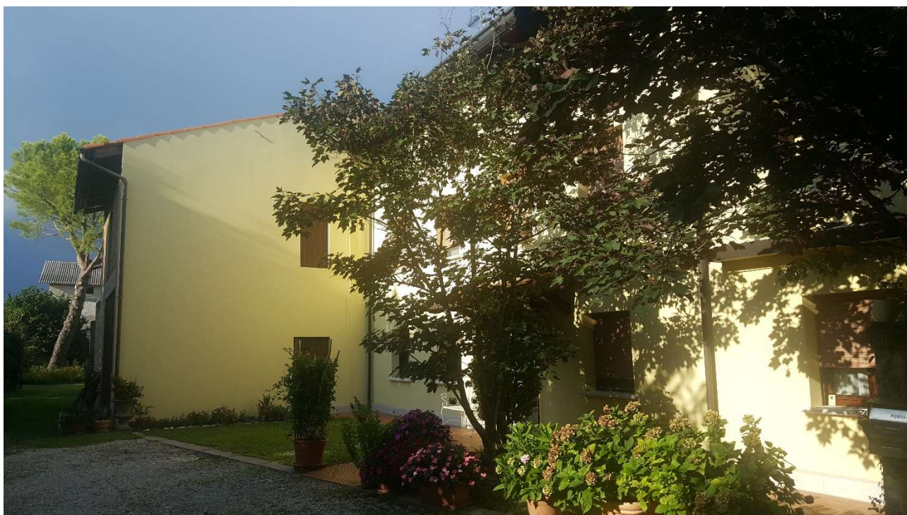
Figura 3 Vista ex fienile
