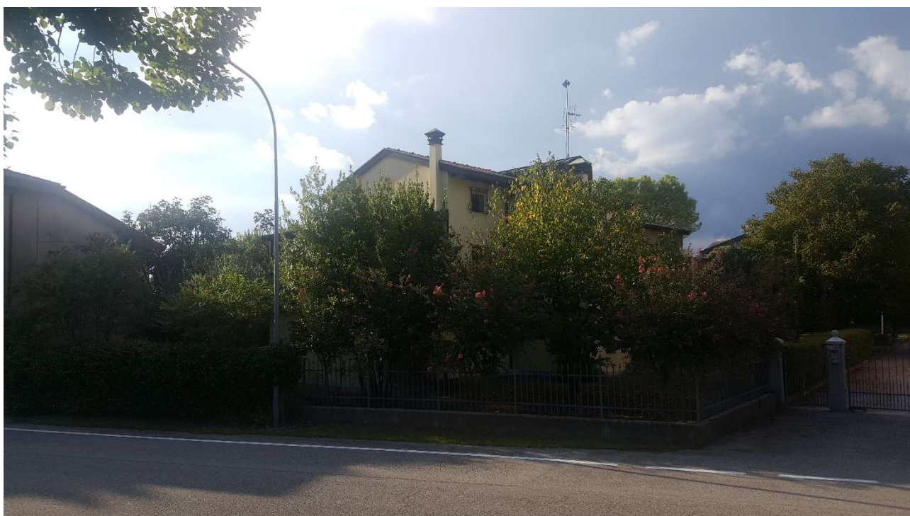
Figura 4 Vista da strada
