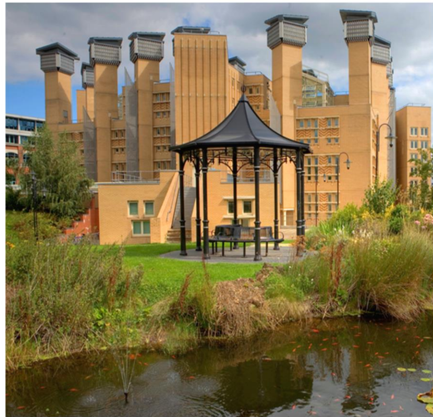
Un esempio (2008) di wind-catching con torri di ventilazione (Lancaster Library, Coventry University).
