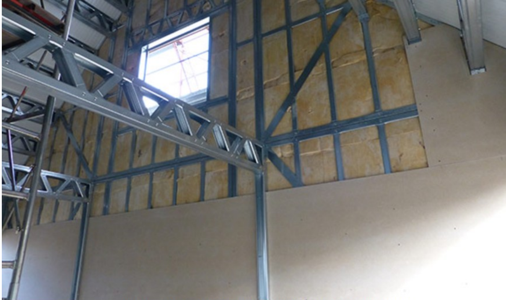
Vista di un sistema costruttivo in profili sottili formati a freddo - foto: Cogi srl
