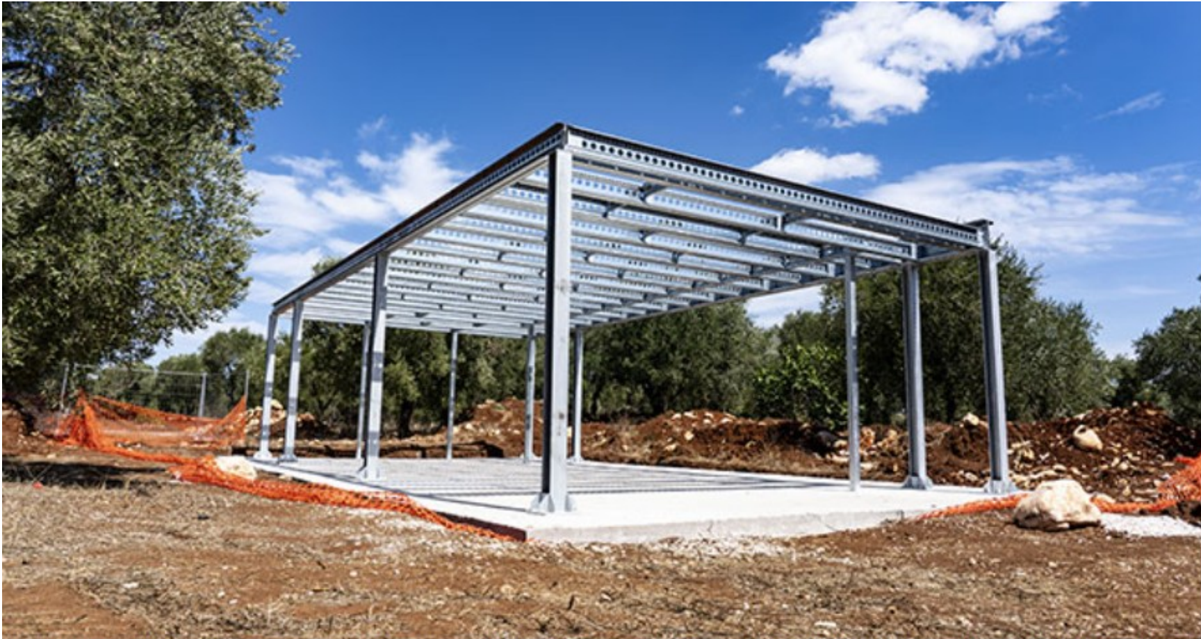
Esempio di realizzazione a secco con colonne in profili laminati a caldo e travi in profili sottili formati a freddo - foto: Scaff System srl
