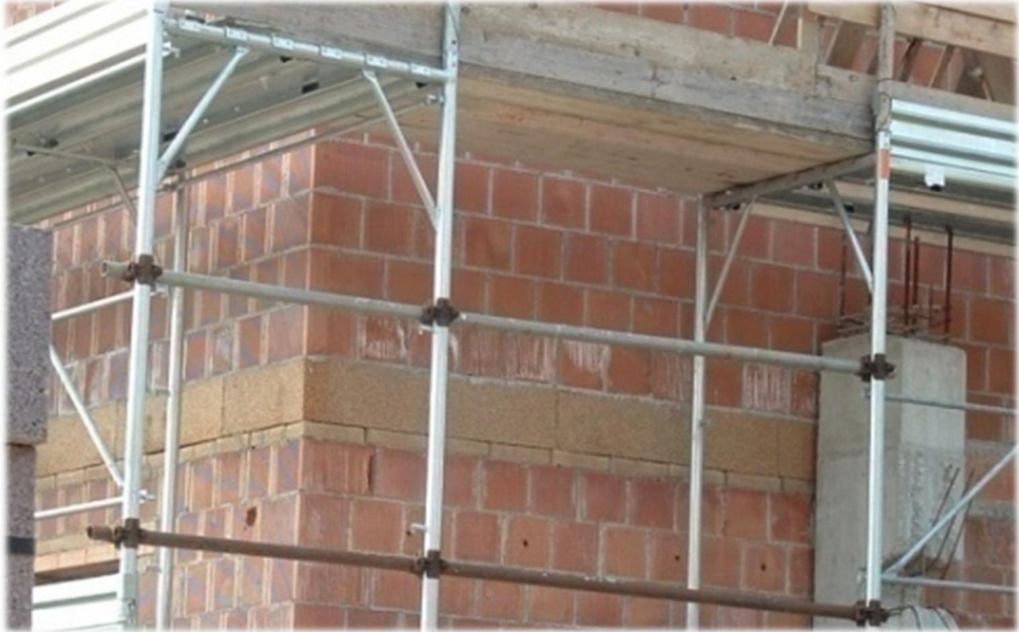
Striscia perimetrale per la correzione del ponte termico solaio – parete perimetrale
