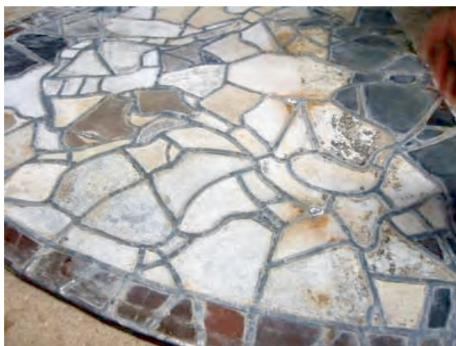
Figura 6.10: Una vetrata della cattedrale di León, in Spagna, che mostra segni evidenti di corrosione, fenomeno che può essere studiato anche mediante diffrazione di raggi X da polveri. Immagine riprodotta per gentile concessione di María Ángeles Villegas e contenuta nella sua pubblicazione “Degradación y conservación de vidrieras medievales” apparsa il 31 maggio 2011 nella rivista Interempresas.
