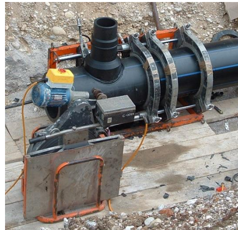
Figura 6 Rete di distribuzione acqua refrigerata 7°C e antincendio - Parco Nord di Udine - Posa in opera di tubi in PEHD PN16 D.560-450-400-355-315-280 e diametri inferiori per un totale di 6 KM
