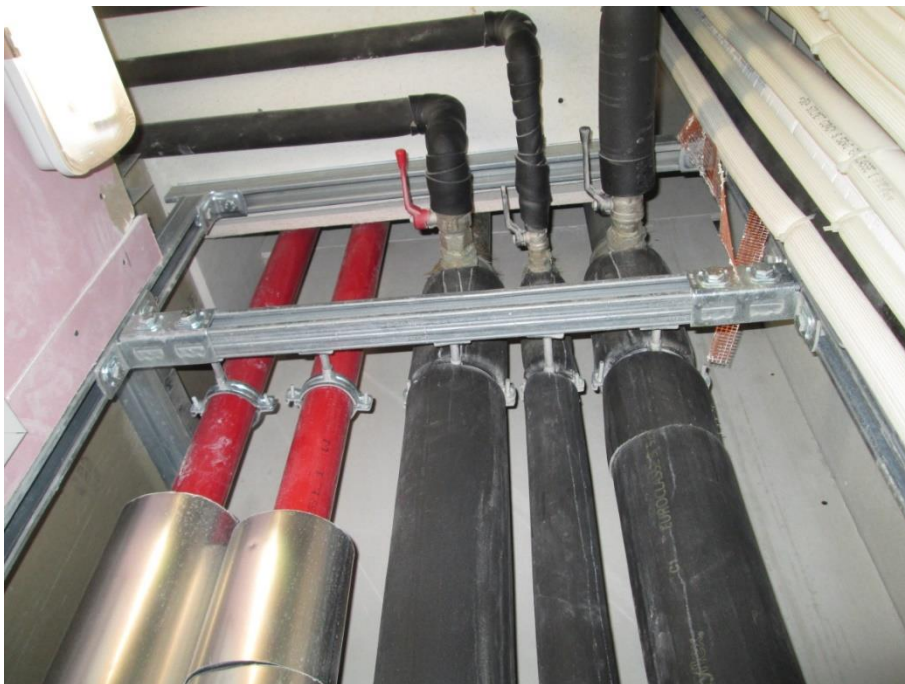
Figura 10 Installazione delle reti di tubazioni entro cavedio
