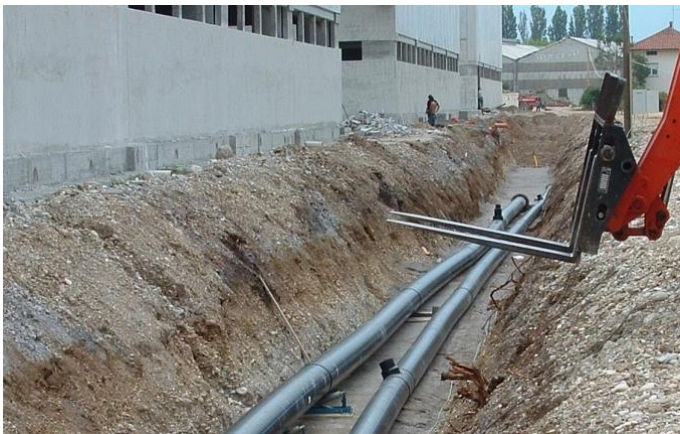
Figura 6 Rete di distribuzione acqua refrigerata 7°C e antincendio - Parco Nord di Udine - Posa in opera di tubi in PEHD PN16 D.560-450-400-355-315-280 e diametri inferiori per un totale di 6 KM
