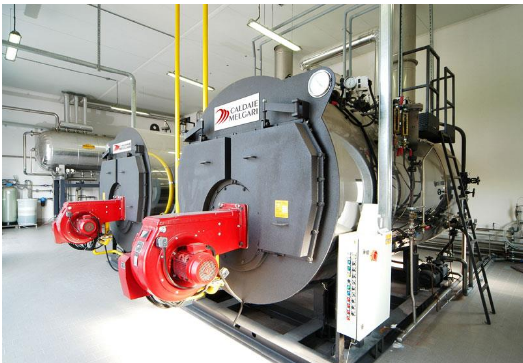
Figura 82 Generatore di vapore a tubi di fumo
