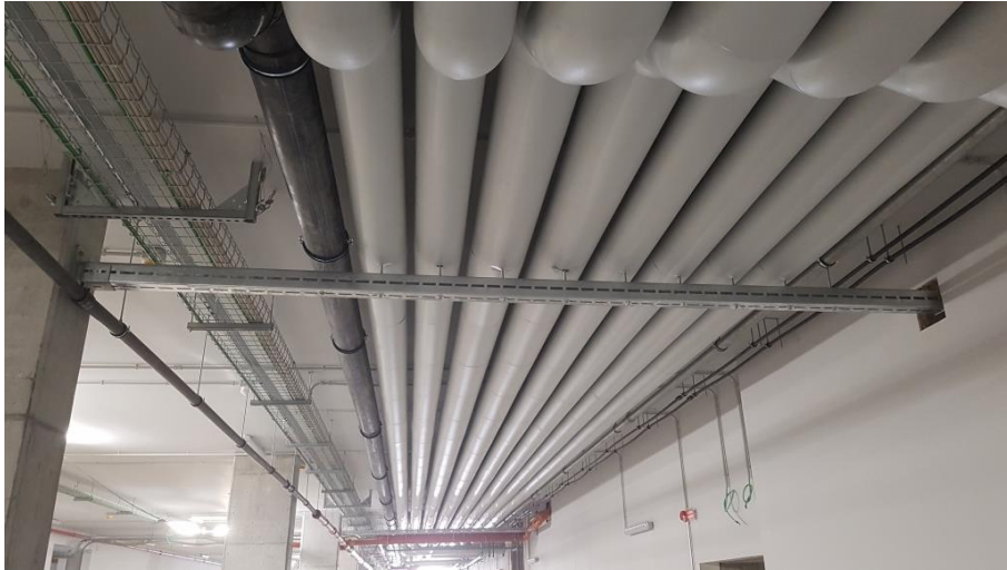
Figura 9 Installazione delle reti di tubazioni a controsoffitto
