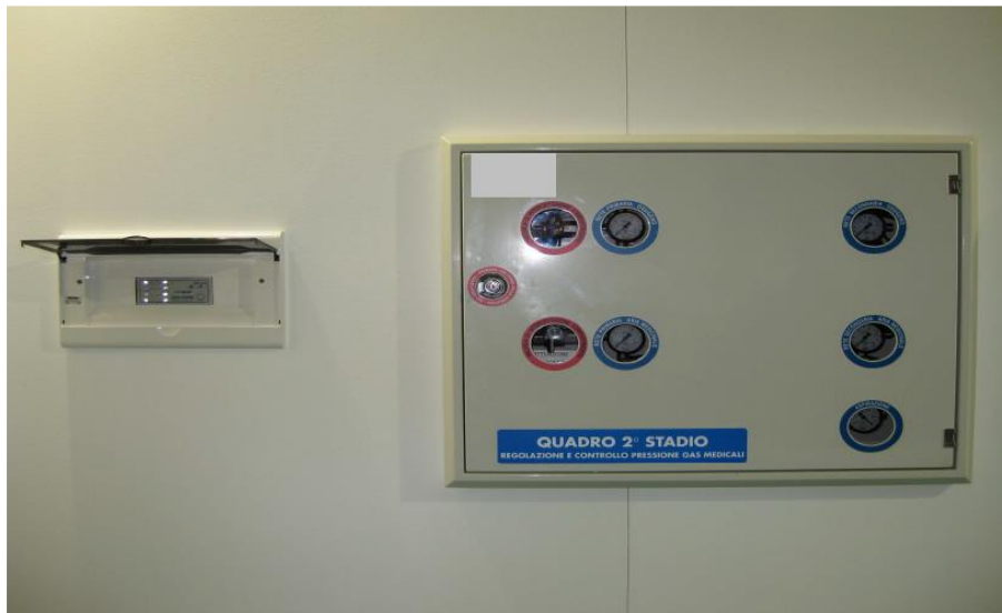
Figura 124 Quadro di riduzione di II stadio e relativi allarmi
