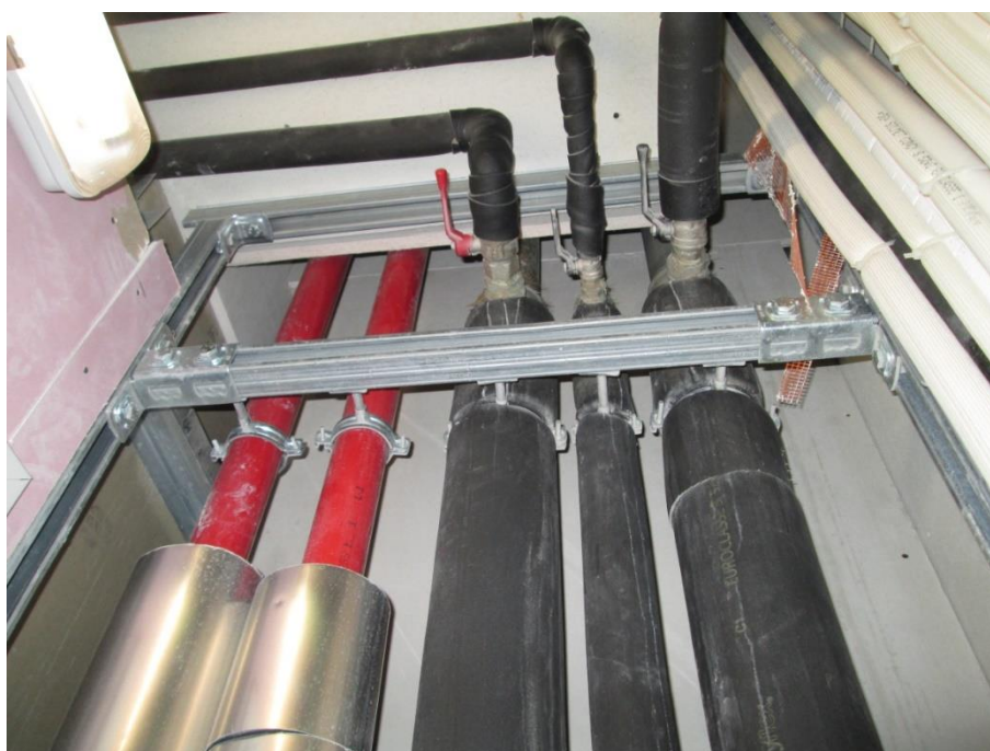
Figura 10 Installazione delle reti di tubazioni entro cavedio
