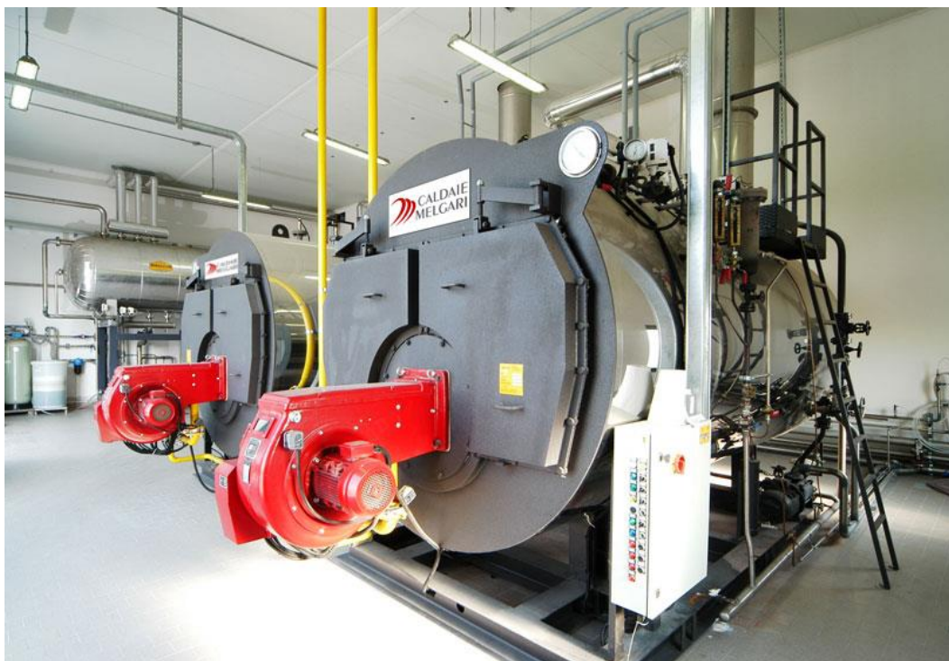
Figura 82 Generatore di vapore a tubi di fumo
