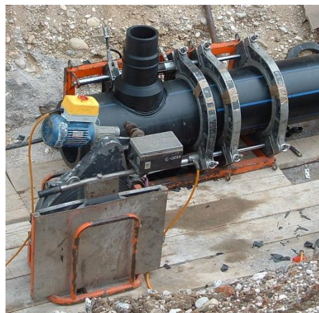
Figura 6 Rete di distribuzione acqua refrigerata 7°C e antincendio - Parco Nord di Udine - Posa in opera di tubi in PEHD PN16 D.560-450-400-355-315-280 e diametri inferiori per un totale di 6 KM
