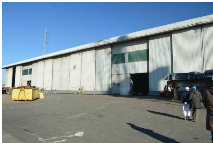
Figura 147. Capannette di Pitturazione – Fabbricato
