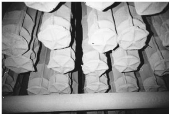
Figura 68 Vista delle maniche in condizioni di lavoro
