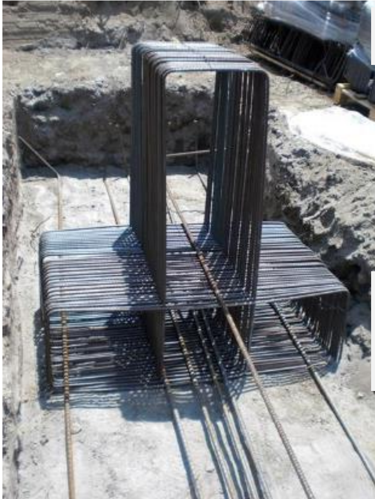
Travi rovesce monodirezionali
