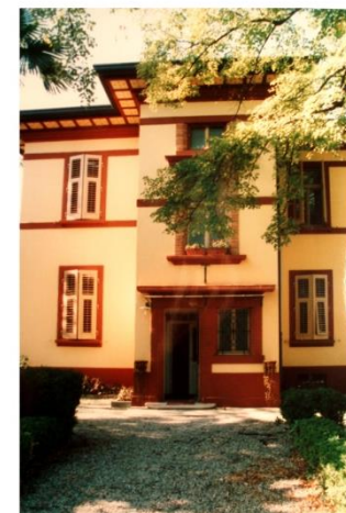
Il villino dopo la ristrutturazione. 2003.
