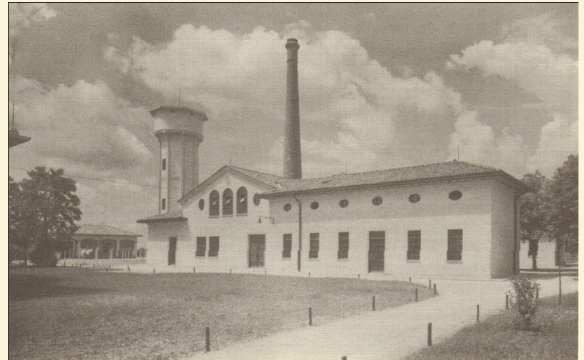
La centrale termo-elettrica e lavanderia.
