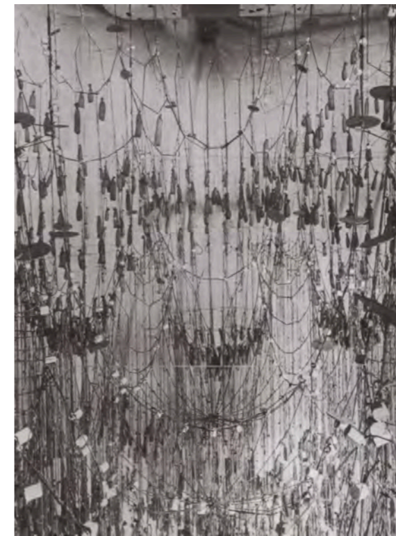
3 Antoni Gaudí, studio per la progettazione delle coperture della Sagrada Família (Barcellona)
