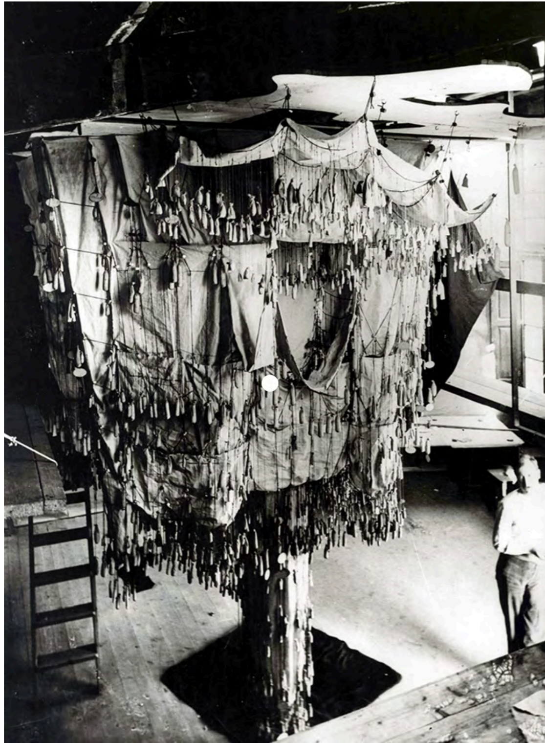
3 Antoni Gaudí, studio per la progettazione delle coperture della Sagrada Família (Barcellona)
