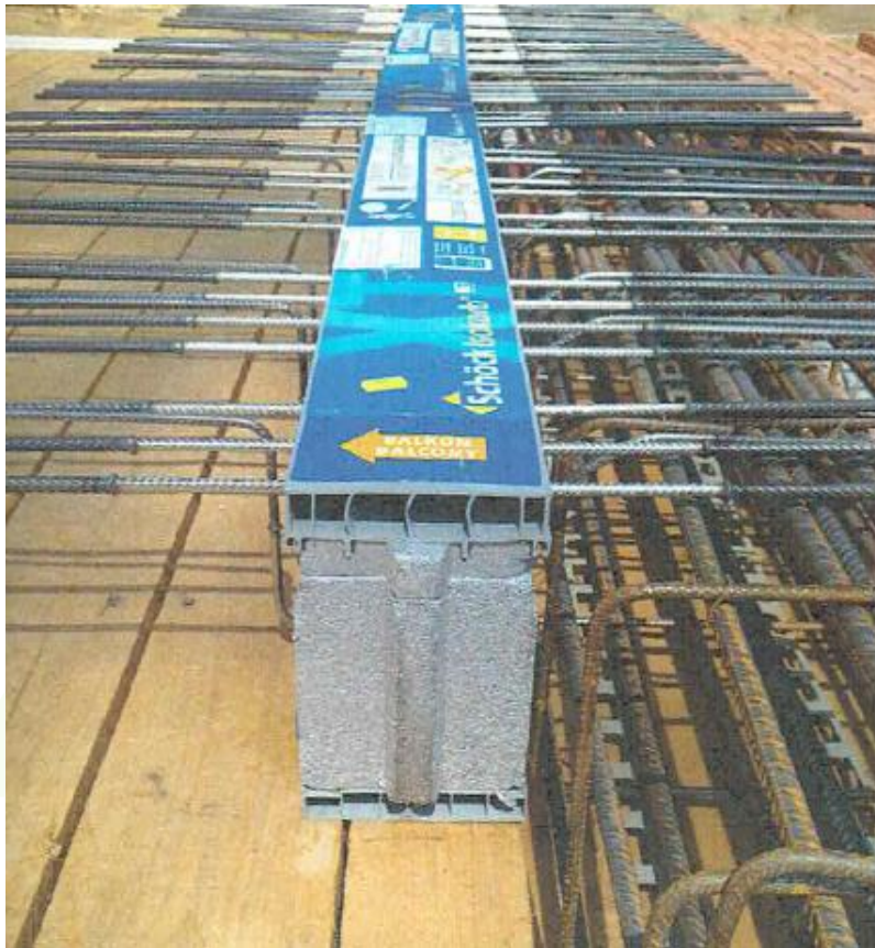
A sinistra, armatura della trave di bordo. A destra, armatura di ripresa per soletta a sbalzo.
