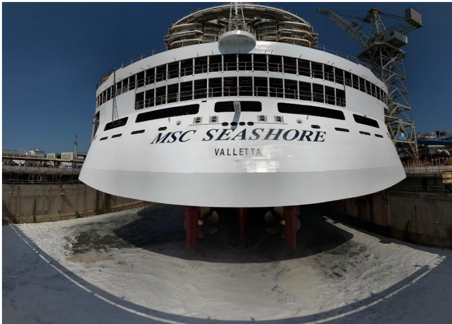
Figura 65 Varo tecnico: allagamento del bacino
