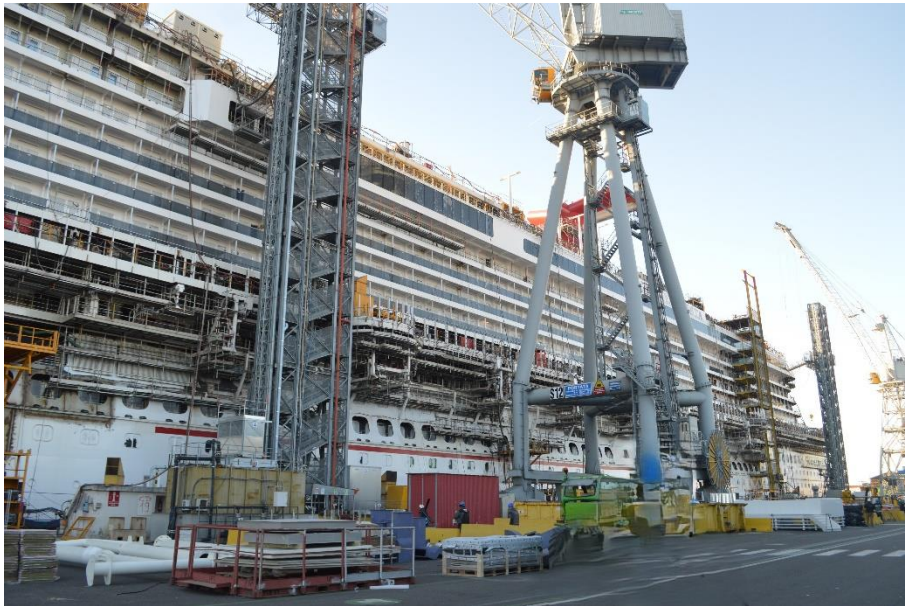
Figura 66 Banchina di allestimento
