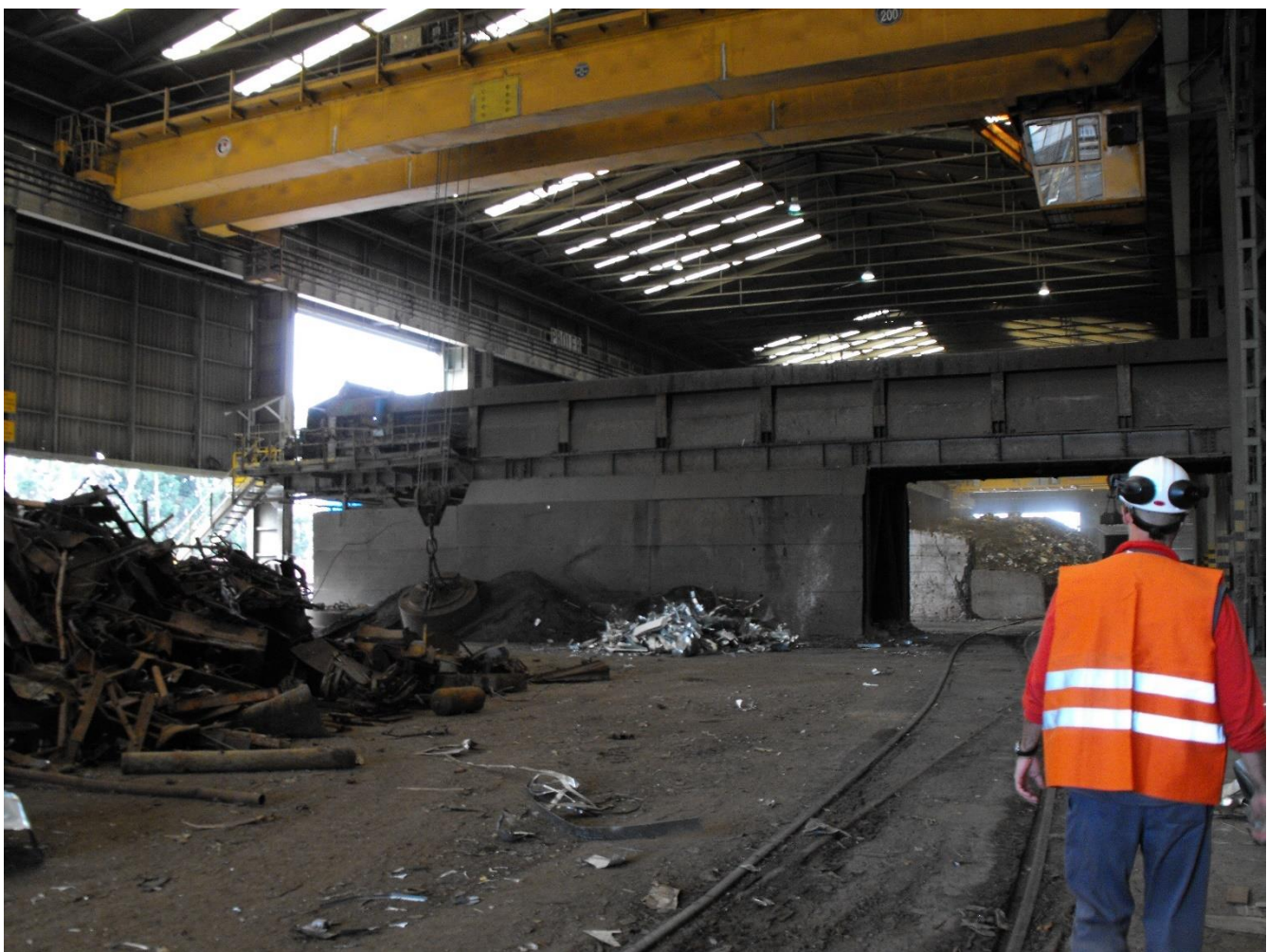
Figura 74 Carroponete dotato di magnete per lo scarico dei vagoni ferroviari
