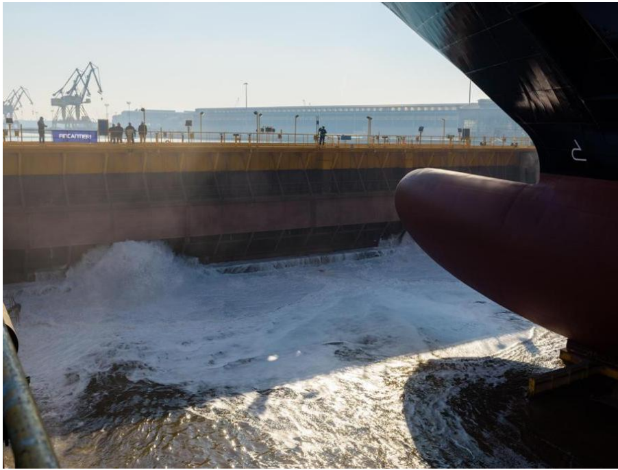
Figura 49 Varo tecnico: allagamento del bacino
