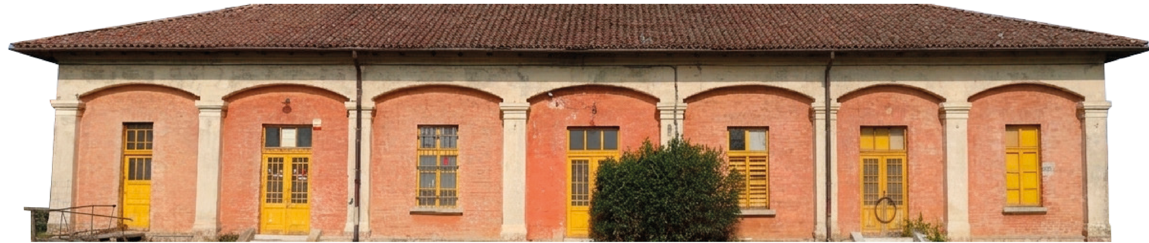
FOTO DEL PROSPETTO SUD stato attuale
