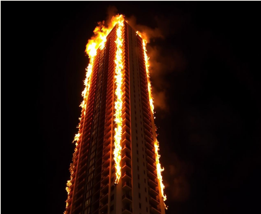
Grenfell Tower, Londra (2017) — 72 vittime. Il rivestimento in pannelli ACM accelerò la propagazione verticale del fuoco lungo la facciata.
