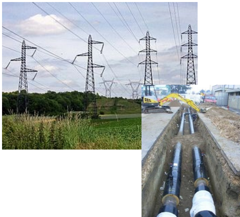
Linee elettriche aeree ed interrattate
