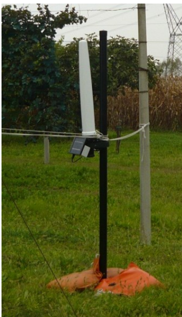
Centralina di monitoraggio in banda larga
