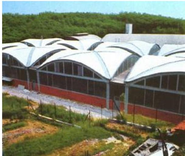
Figura 45 Volta a crociera con raccordi circolari per lucernai falcati.
