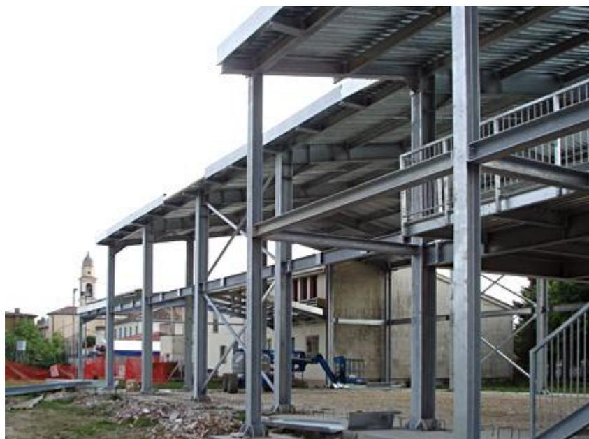
Figura 41 Rappresentazione schematica di un fabbricato industriale in acciaio
