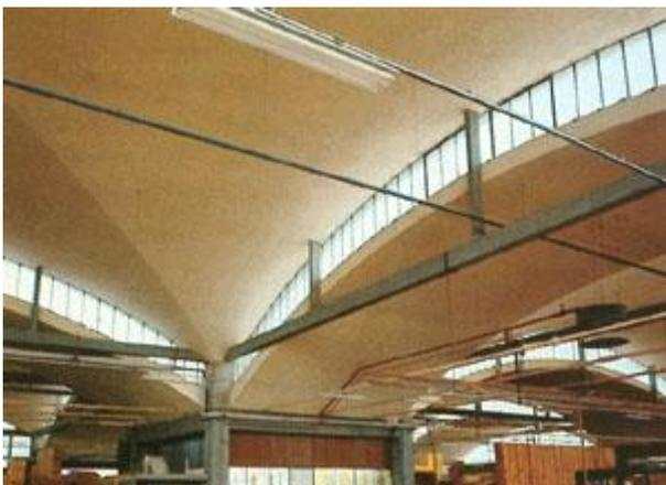
Figura 46 Deposito autobus a Pescara coperto con 8 volte a vela di luce m 30x30 con corsie piane.
